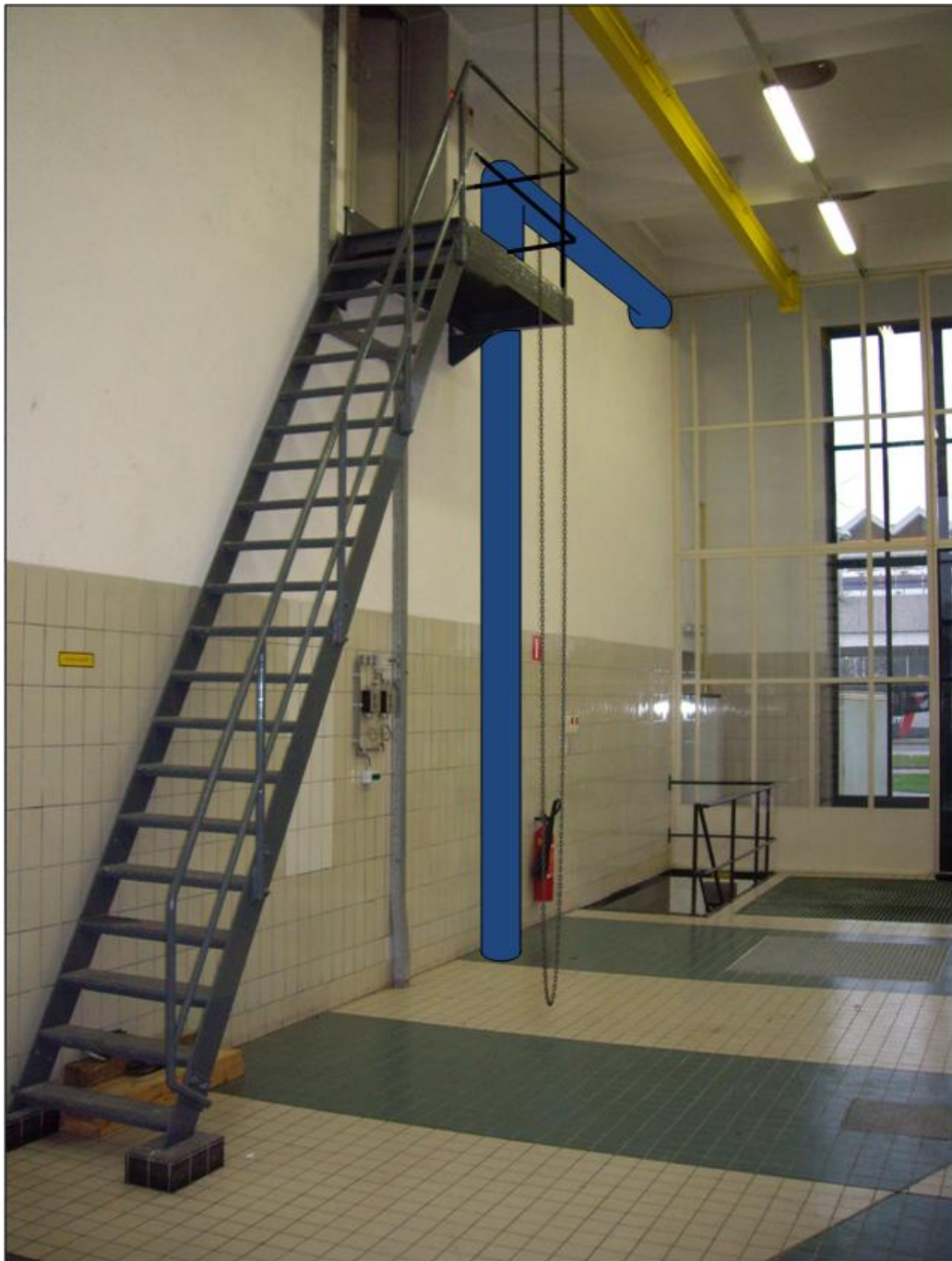
Aan te brengen ventilatiekanaal in de schakelruimte t.b.v. kelderventilatie
